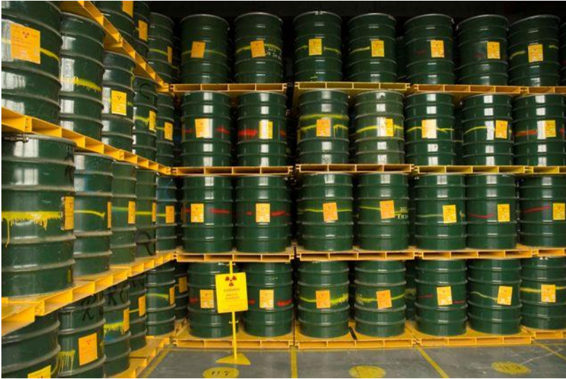
DEPÓSITO INICIAL - Central Nuclear Almirante Álvaro Alberto (CNAAA)
