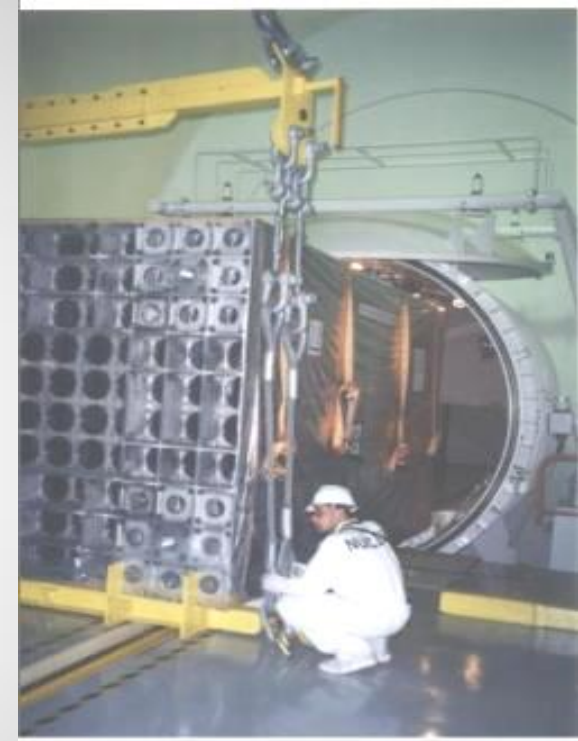
RACKS SUPERCOMPACTOS PARA ANGRA 2
